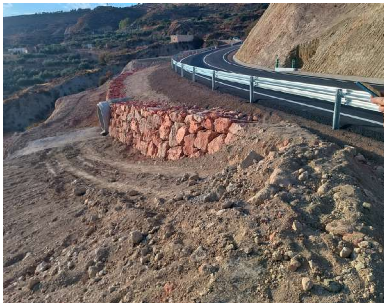
Obras estabilización ladera Ctra. a-1075
