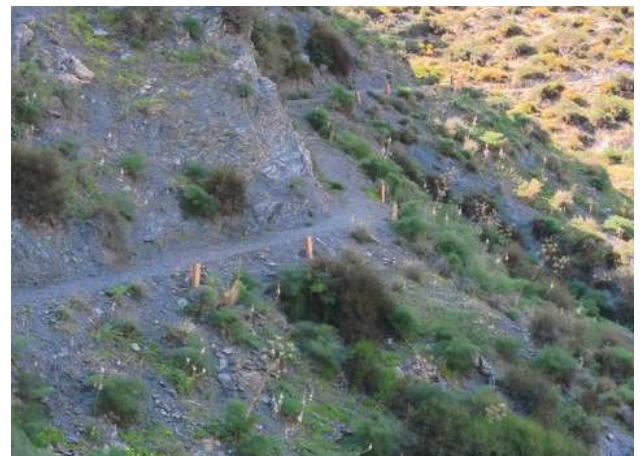
Mantenimiento de dos tramos del sendero Cordel Solana
